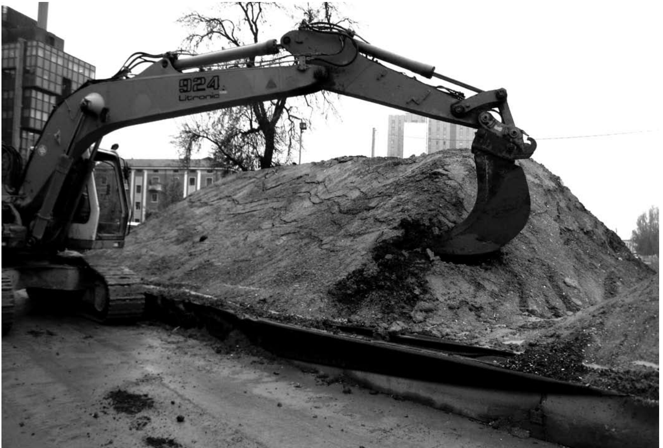
Scavi in cantieri edili
